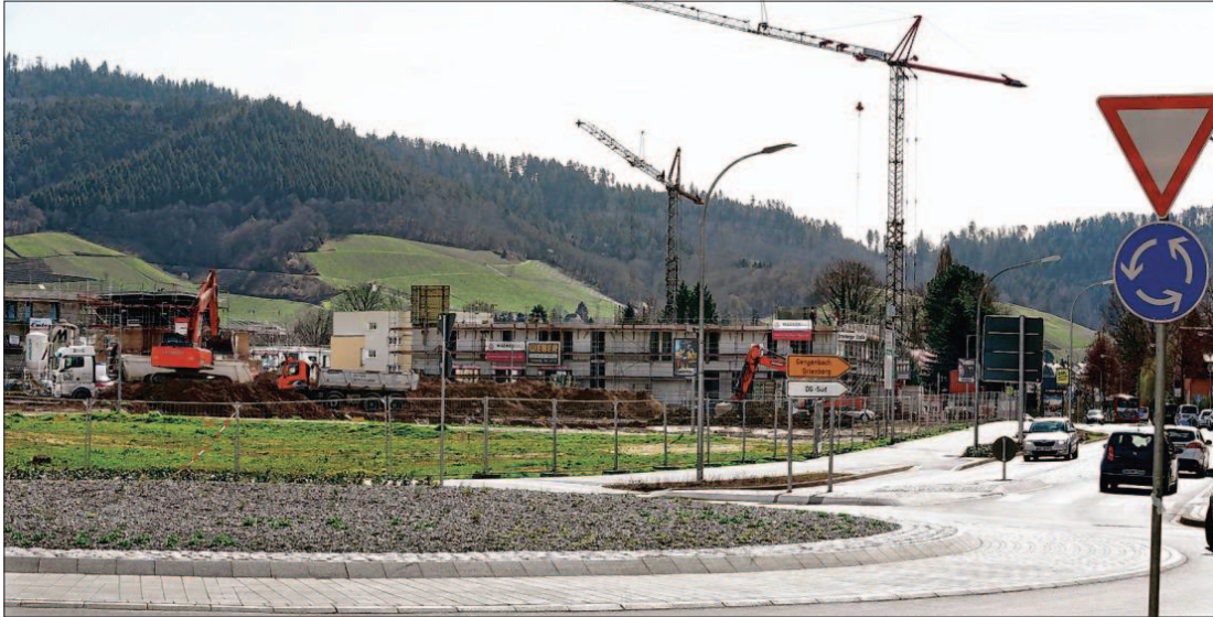
Am vergangenen Mittwoch haben die ersten Arbeiten zum Bau von fünf Mehrfamilienhäusern der Wohnbau Offenburg im »Seidenfaden« begonnen. Das Foto zeigt im Vordergrund den neuen Kreislauf an der Ortenberger Straße (rechts), dahinter ist die Baustelle mit den Baggern zu sehen. Die oberste Bodenschicht ist bereits abgetragen worden. Fotos: Ulrich Marx
