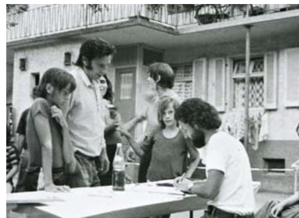
Die Bewohner konnten intensiv bei der Sanierung mitwirken
