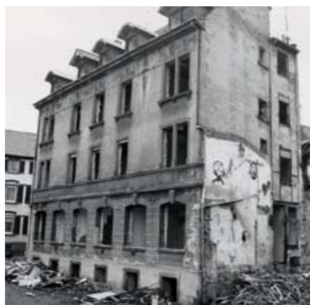
Viele Gebäude mussten abgerissen werden, da sich eine Sanierung nicht mehr lohnte
