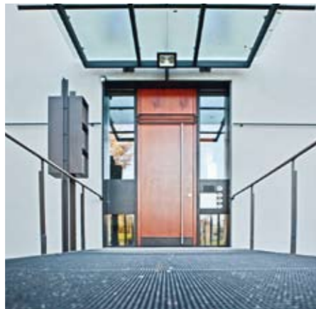
1997 zog die Wohnbau in die Geschäftsstelle in der Franz-Ludwig-Mersy-Straße um
