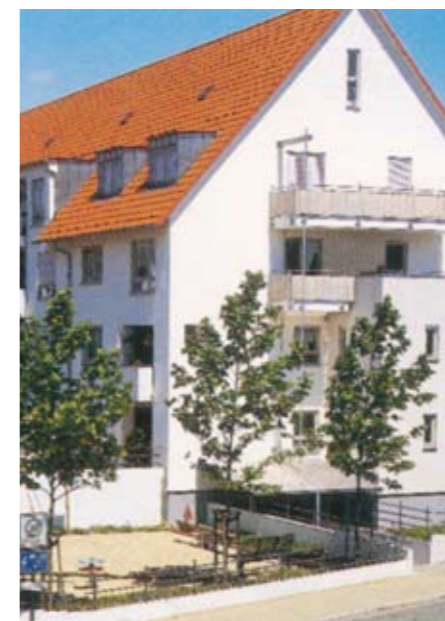
In der Kinzigvorstadt wurde in den 80er-Jahren alte Bausubstanz durch Neubauten ersetzt
